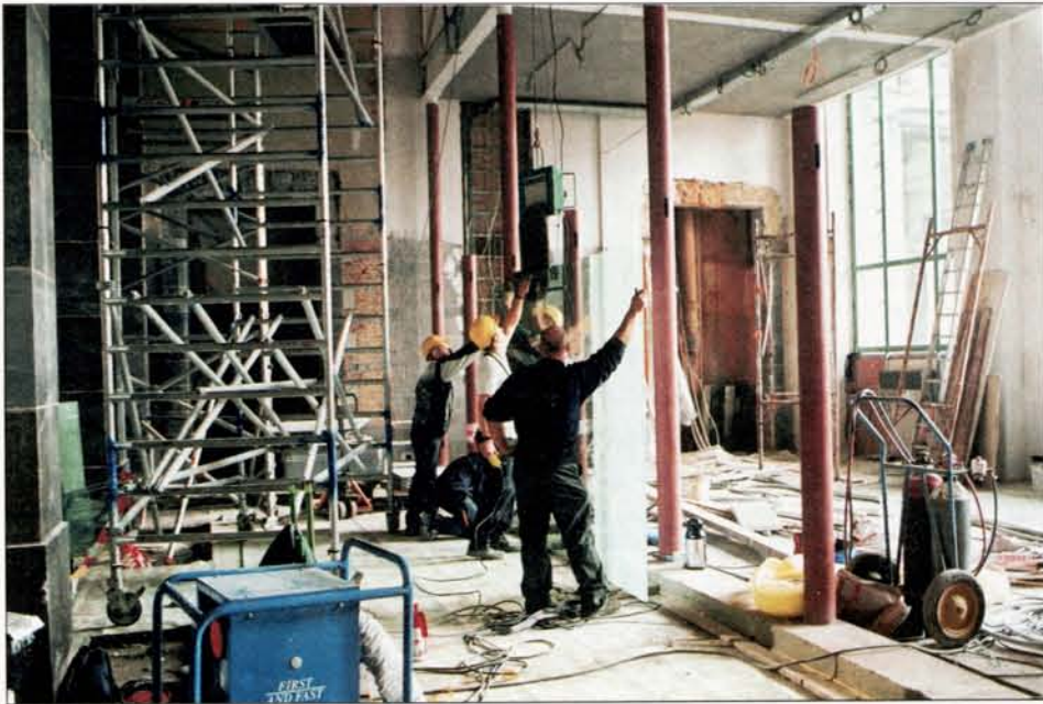
Vanaf eind april 2002 kunnen de reizigers gebruik maken van het nieuwe Travel Centre in de inkomhal van het station. Momenteel wordt er nog volop gewerkt.
