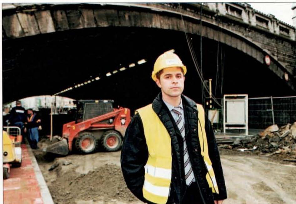
Kurt Scherpereel van TUC RAIL: "De brug Plantin en Moretuslei zal eind maart opnieuw open zijn over de volledige breedte van de weg."
